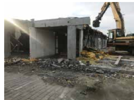
Nedrivning af den eksisterende bygning A
