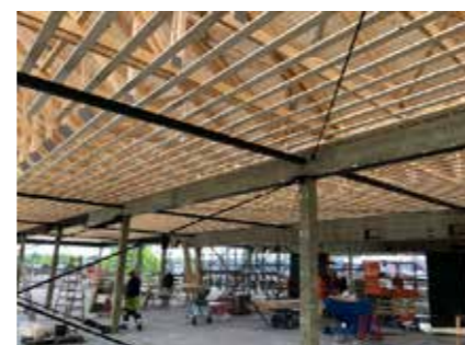
Spærene er rejst og ovenlysene er ved og blive lagt i.
