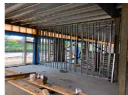
Billede fra stuen, hvor glaspartierne er monteret i facaden og stålet til indervæggene er startet
